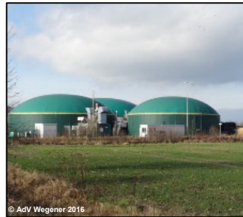
Biogas- anlage Biogas- anlage Biogas- anlage
