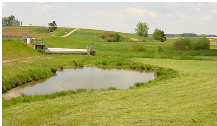
Umsetzung von Hochwasserschutzmaßnahmen
