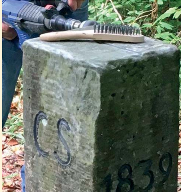
Reinigung eines 1839 gesetzten oder erneuerten Landesgrenzsteins (Die eingemeißelte Rille auf der Kopfseite des Steins zeigt zu den benachbarten Steinen.)
