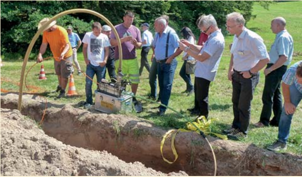
Fachexkursion zum Glasfaserausbau vor Ort
