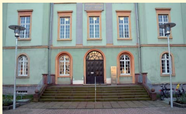
Eingang zum Dienstgebäude in Karlsruhe
